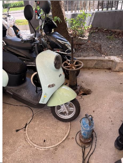
雨排口截止阀、雨水泵
