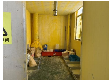
危废仓库防渗、接漏托盘及收集口
